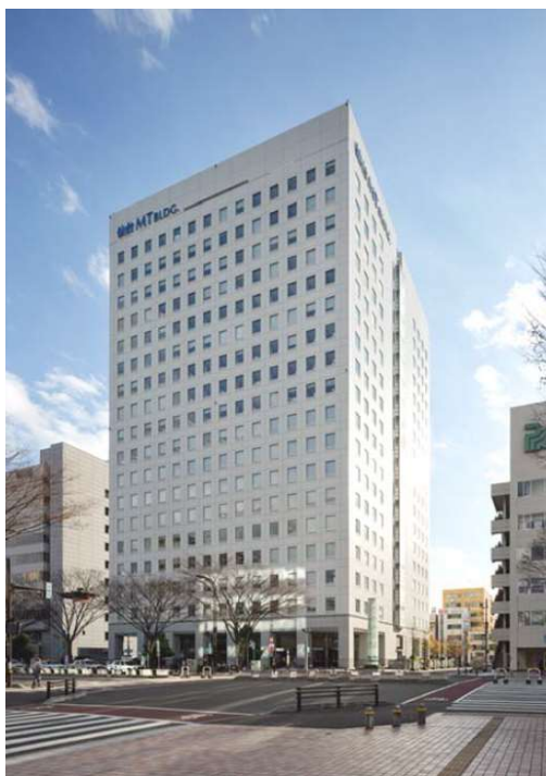
仙台MTビル
