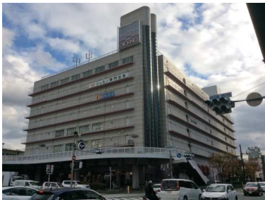
（解体工事開始前の状況）
